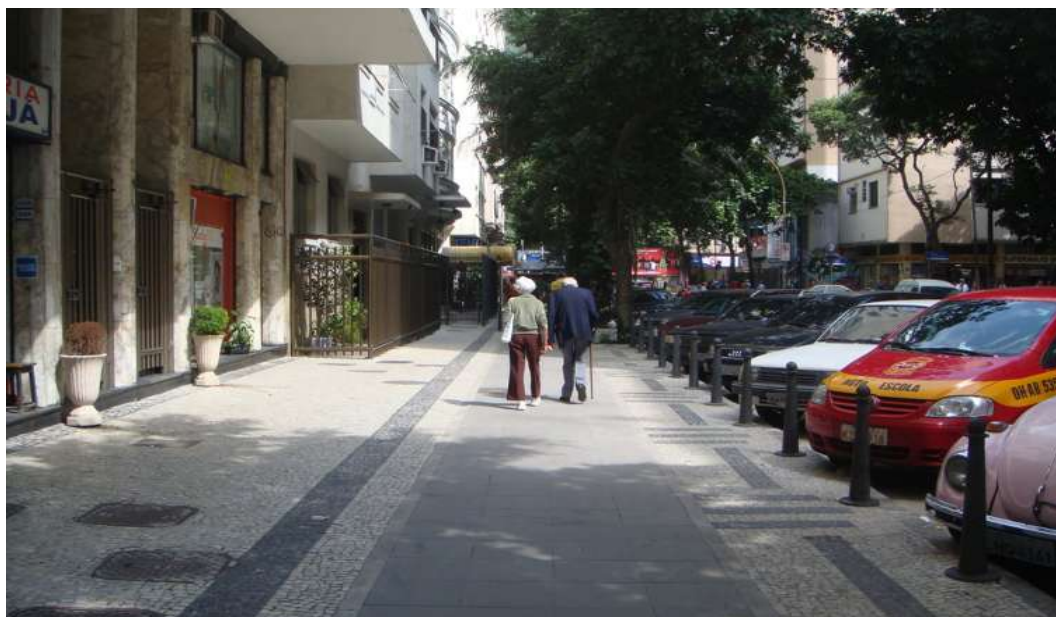
Figura – Rua Rodolfo Dantas Exemplo de calçada com Faixa Livre com Rota Acessível, Faixa de Acesso e Faixa de Serviço. Fonte: PCRJ/SMU.CP, 2017
