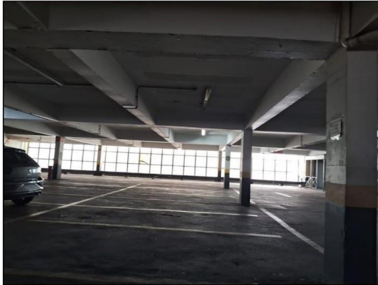
Interior do Estacionamento
