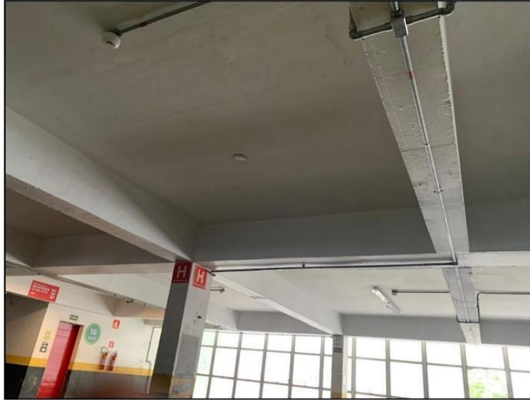
Interior do Estacionamento
