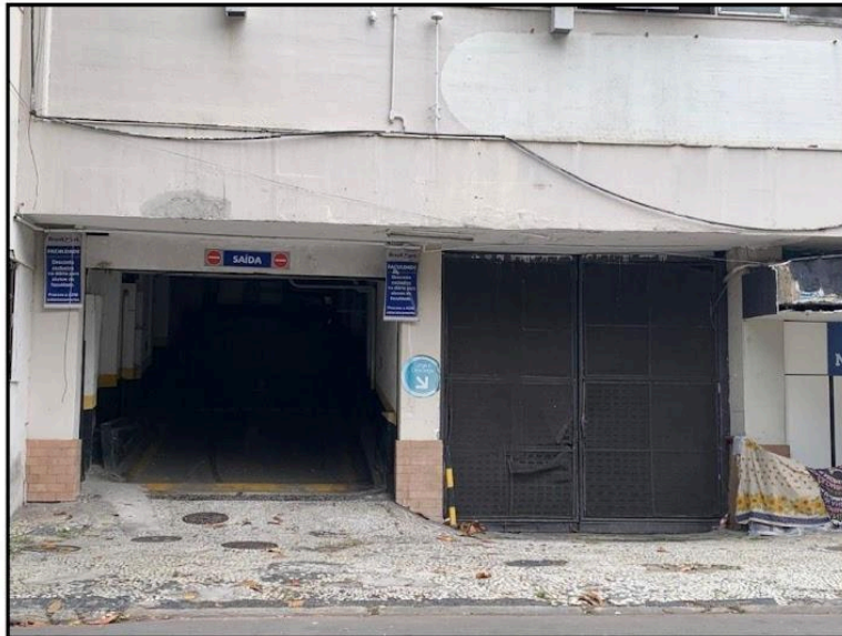
Saída do estacionamento e acesso ao Subsolo (Rua Jornalista Orlando Dantas)
