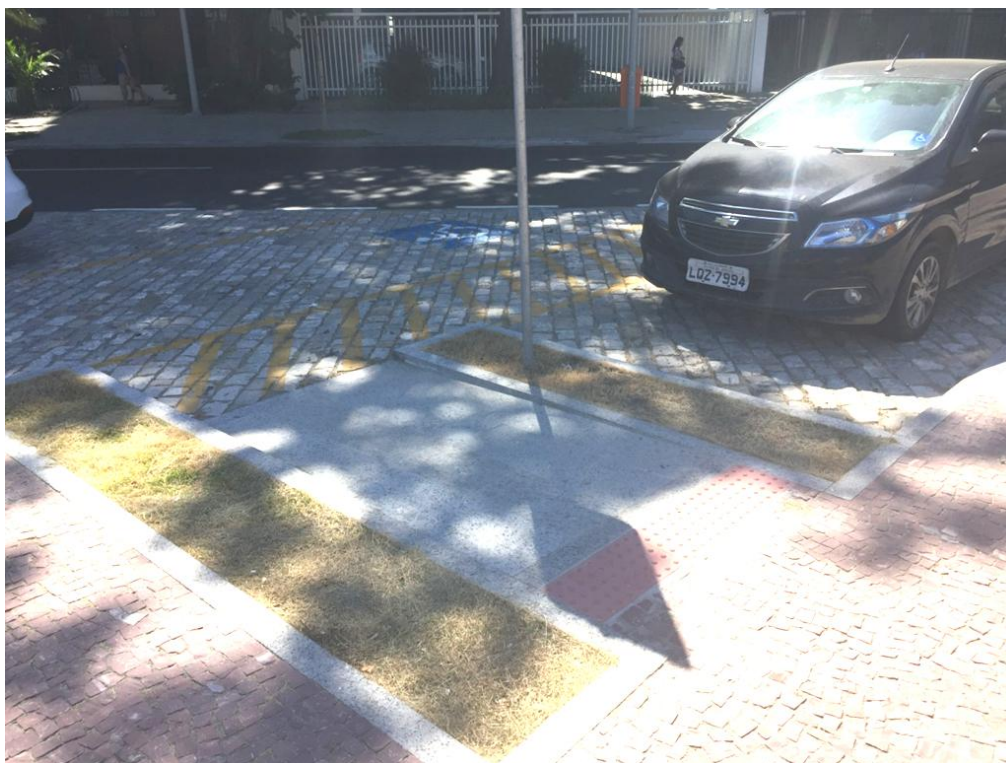
Figura 54 – Exemplo de rampa de acesso à vaga especial. Fonte: PCRJ/ SMU.CP, 2017
